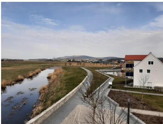
Hochwasserschutz in Wassertrüdingen, 2 km Deich, Mauer und mobile Elemente, Kosten 13,4 Mio. €, davon trug Wassertrüdingen 1,8 Mio. €, Foto März 2025
