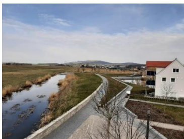
2025 Wassertrüdingen: Hochwasserschutz im Zuge der LGS 2019 gefördert durch Städtebauförderung und RZWas
